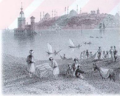
Şekil 3.5 Kız Kulesi'nin eski İstanbul'daki durumunu betimleyen gravür [3]
