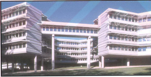
Şekil 2.10 "Union Carbide" Şirketi ana merkez binasının, pencereyi özel büro mekanlarının baktığı dış görünüş. [7]
