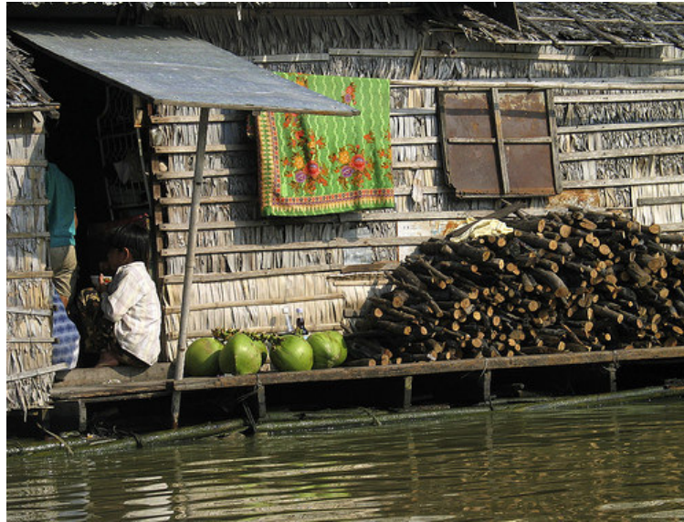
Şekil 3.5 Ağaç yapraklarının yatayda latalarla sabitlenmesiyle oluşturulmuş yapı duvarı (H. Neu)
