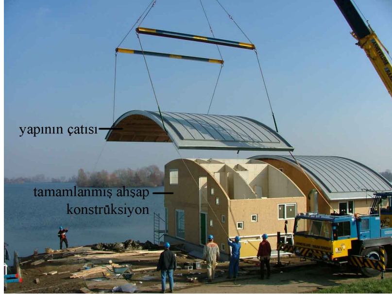
Şekil 4.8 Tamamlanmış yapının üzerine çatısının yerleştirilmesi (Karel Joosten)
