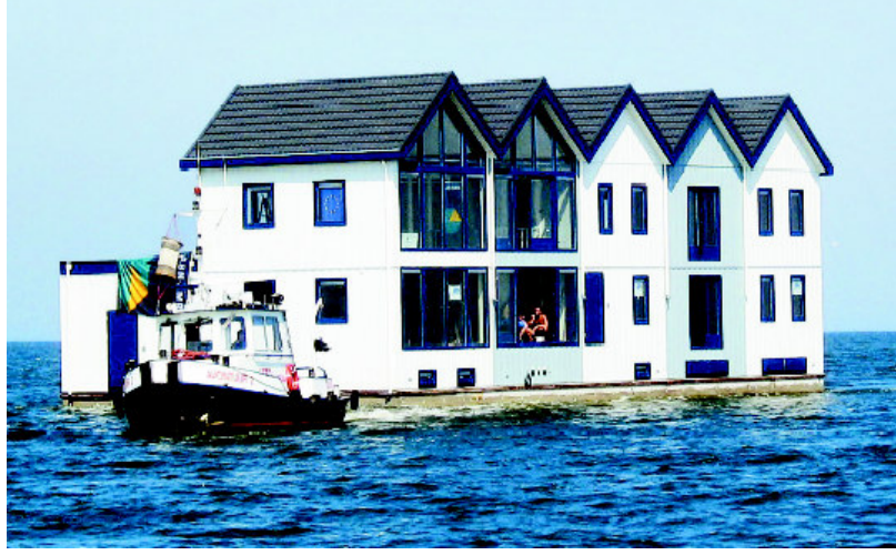
ekil 4.25 Yzen ehirleri oluturacak olan evler rmorklarla istenilen blgeye taınarak monte edilebilir (ABC Ark Builders BV, URK).
