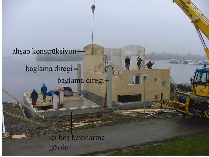
Şekil 4.7 Manşon konstrüksiyon ve beton temellerin üzerine ahşap strüktürün kurulması (Karel Joosten)
