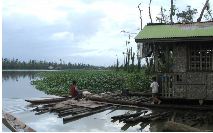
Şekil 3.11 Filipinler’de bambular üzerinde yüzen ev (Ties Rijcken)
