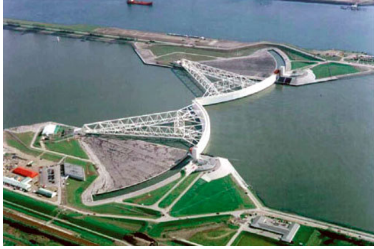
Şekil 4.2 Rijn Nehri ağzındaki fırtına dalgası bariyeri ( www.neeltjeans.nl )
