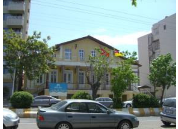
Şekil 4.47 Sahil Sıhhiye binası
