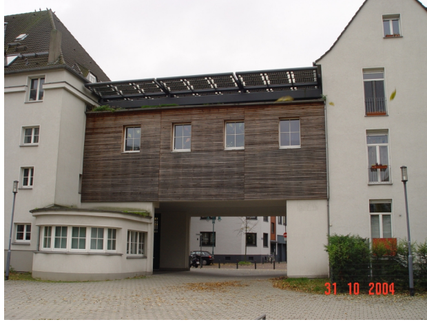
Şekil 5.17. Proje kapsamında kanalların temizlenmesini amacıyla kullanılacak enerjinin üretildiği solar paneller (B.Haznedar arşivi)
